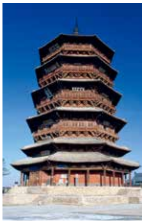
图7-18 山西应县木塔
