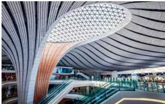
图7-4 北京大兴国际机场
